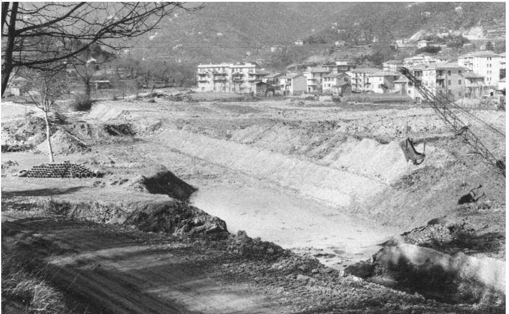
La buca n. 5 prima e durante i lavori di sbancamento e di spostamento del fiume
