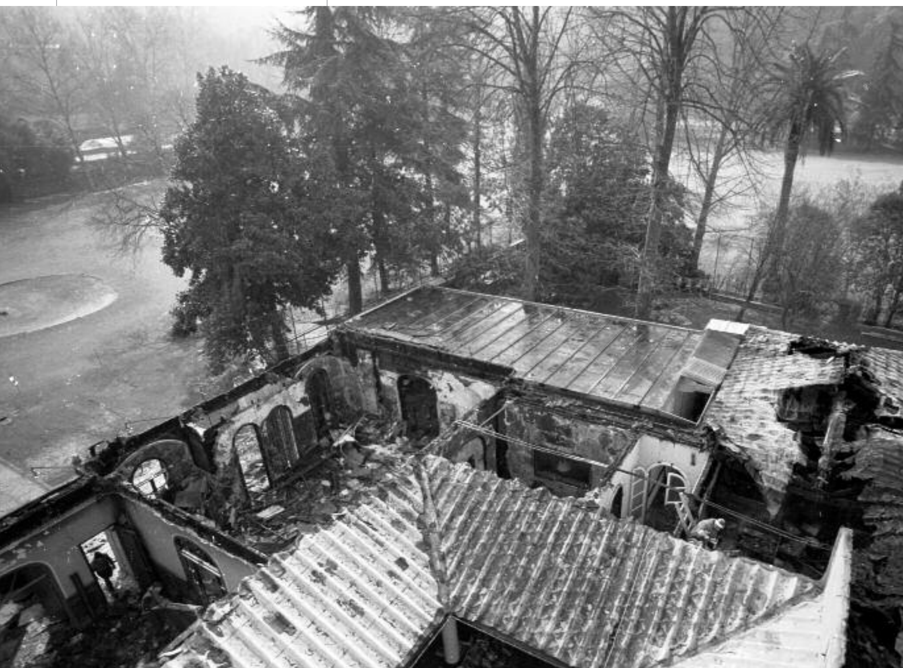
Marzo 1987 Quello che resta della Club House dopo l'incendio
