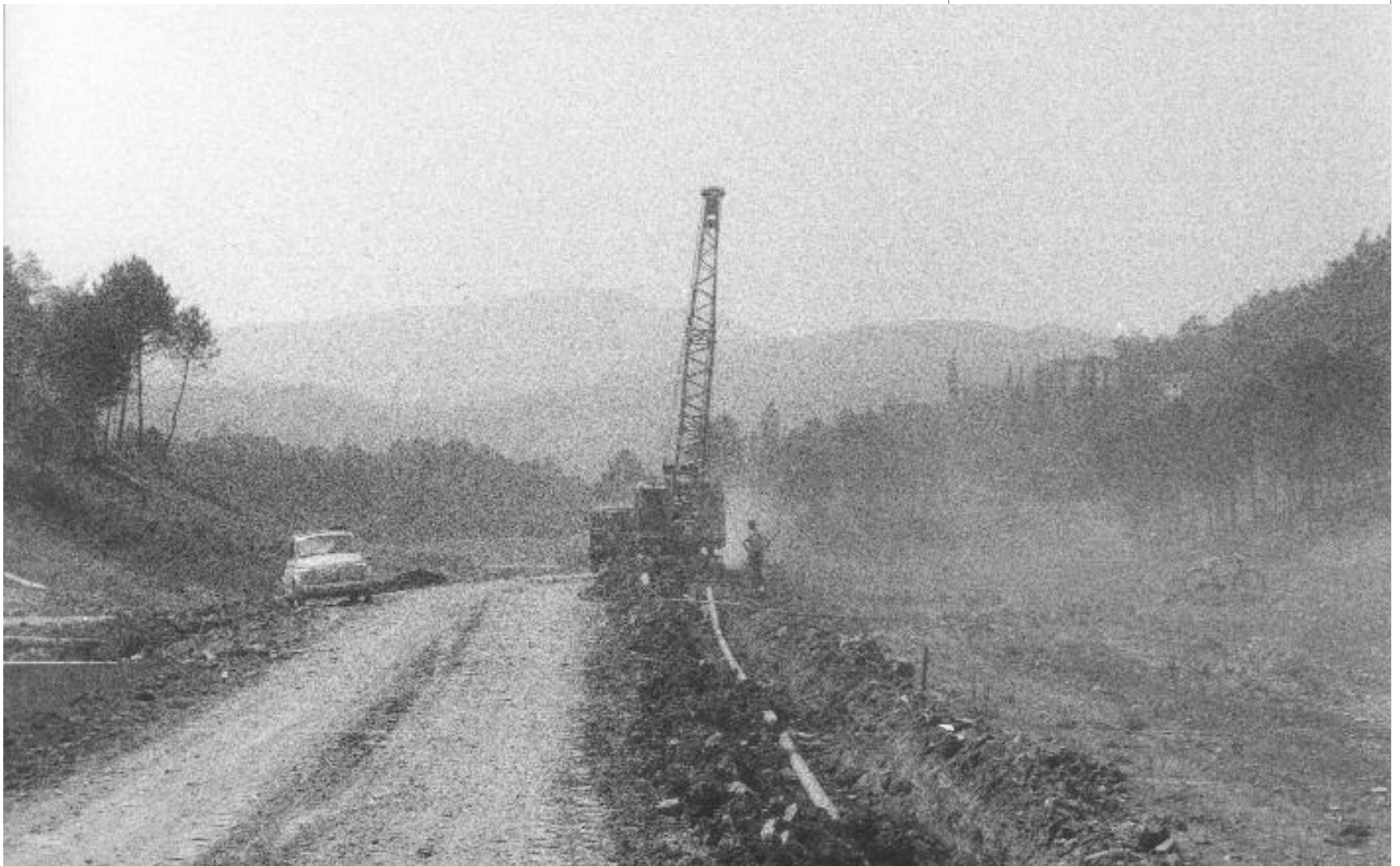
Scavi di drenaggio alla buca n. 12
